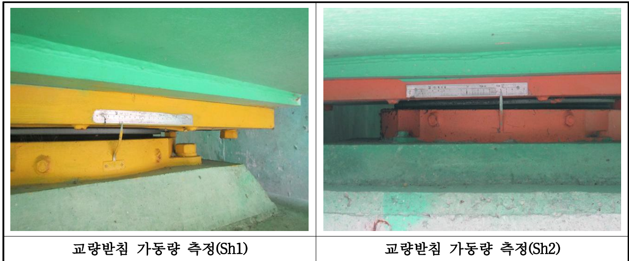
【사진 3.36】 교량받침 가동량 측정 전경
