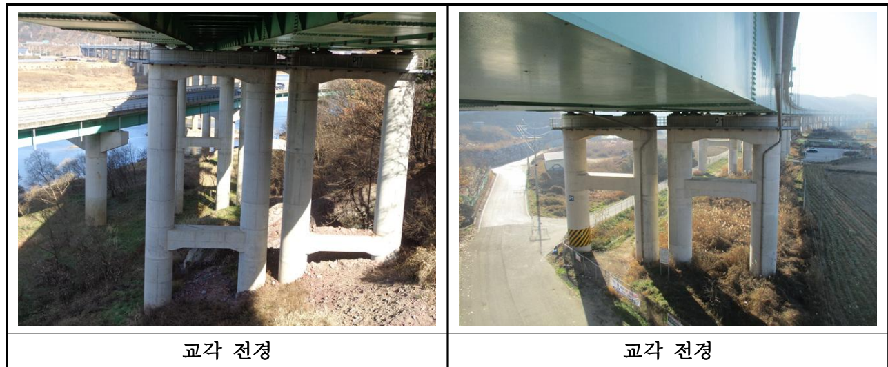
【사진 3.11】 교각 전경
