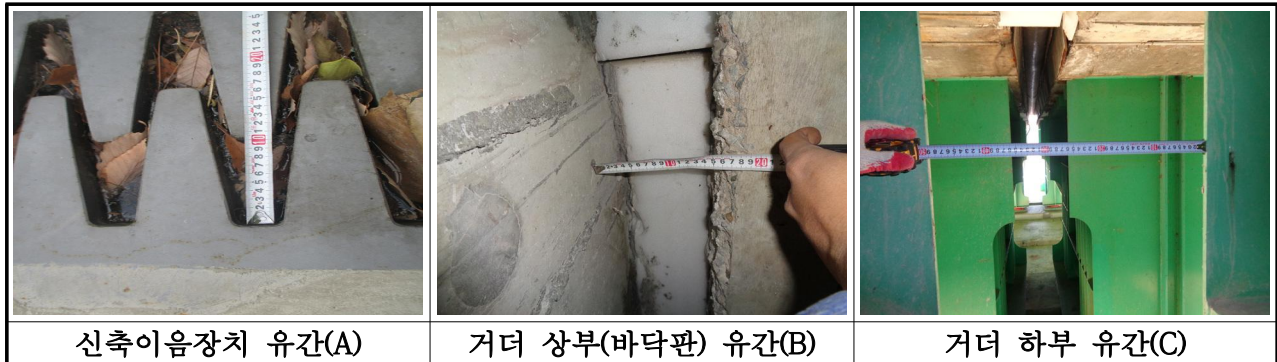
【사진 3.39】 신축이음 유간 측정방법
