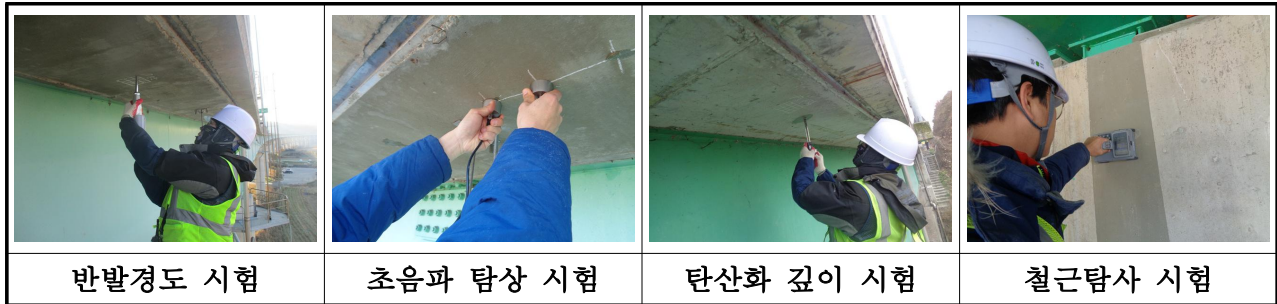
【사진 3.46】 콘크리트 내구성조사 전경
