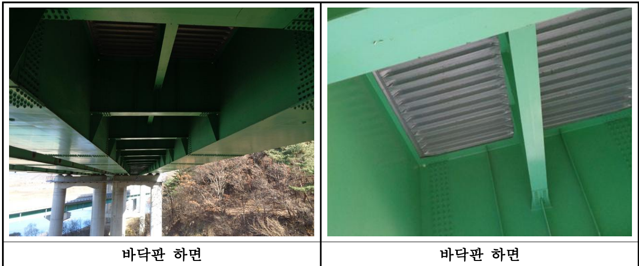
【사진 3.24】 바닥판 전경
