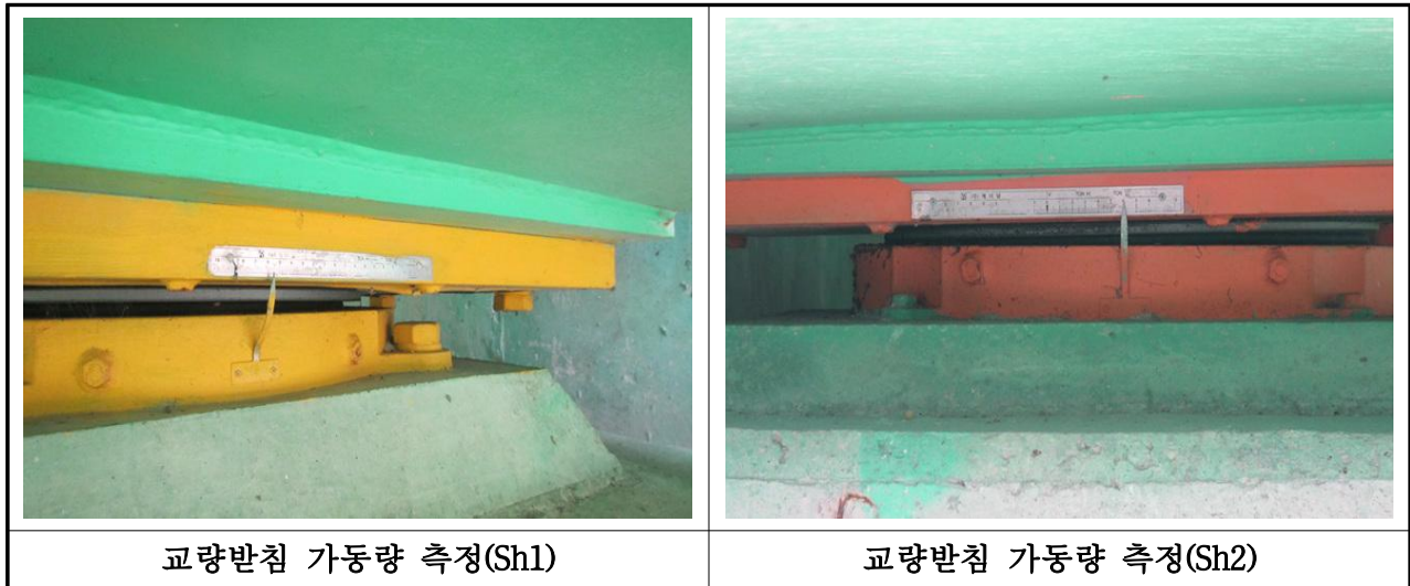
【사진 3.14】 교량받침 가동량 측정 전경
