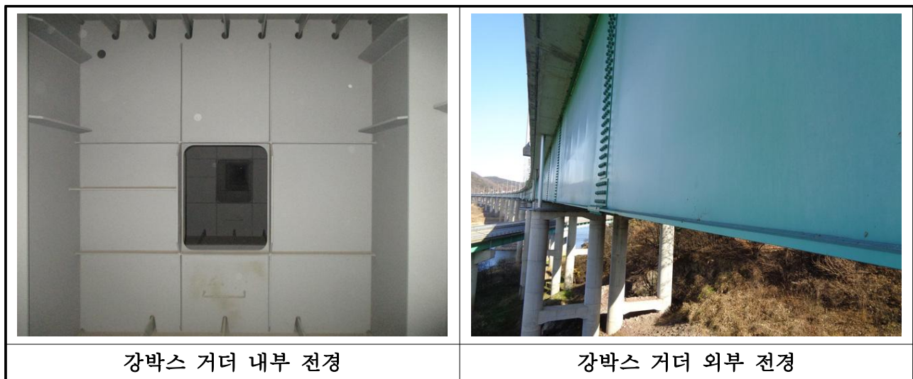
【사진 3.4】 강박스 거더 전경
