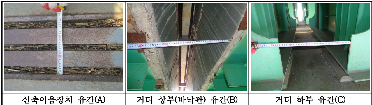
【사진 3.17】 신축이음 유간 측정방법
